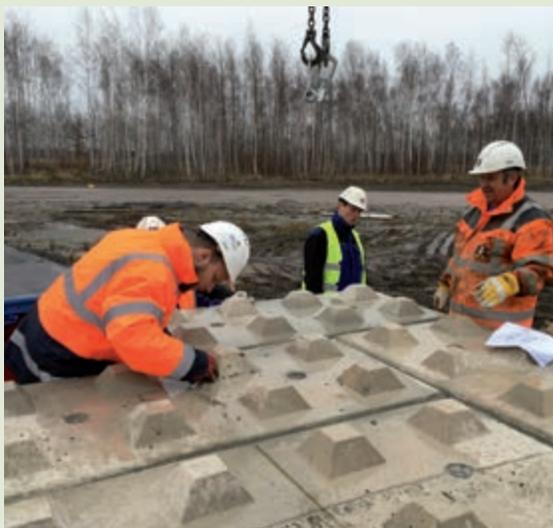
Aufbau der Probelastungssteine
