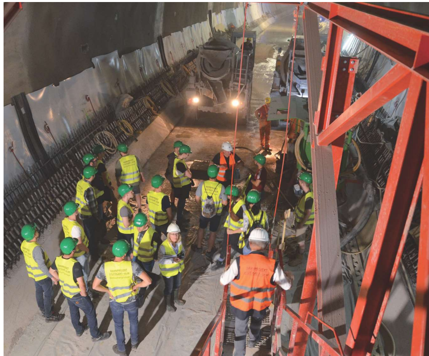
Abstieg von einem Sohlbetonagewagen bei der Exkursion in einem Tunnel von Stuttgart 21
