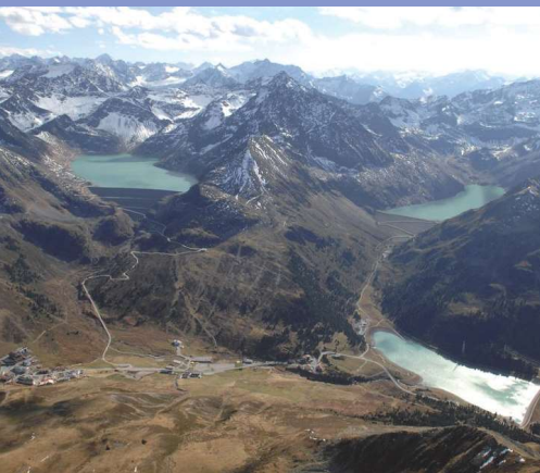
Gesamtansicht der Kraftwerksgruppe Sellrain-Silz (Diplomarbeit E. Spörr)
